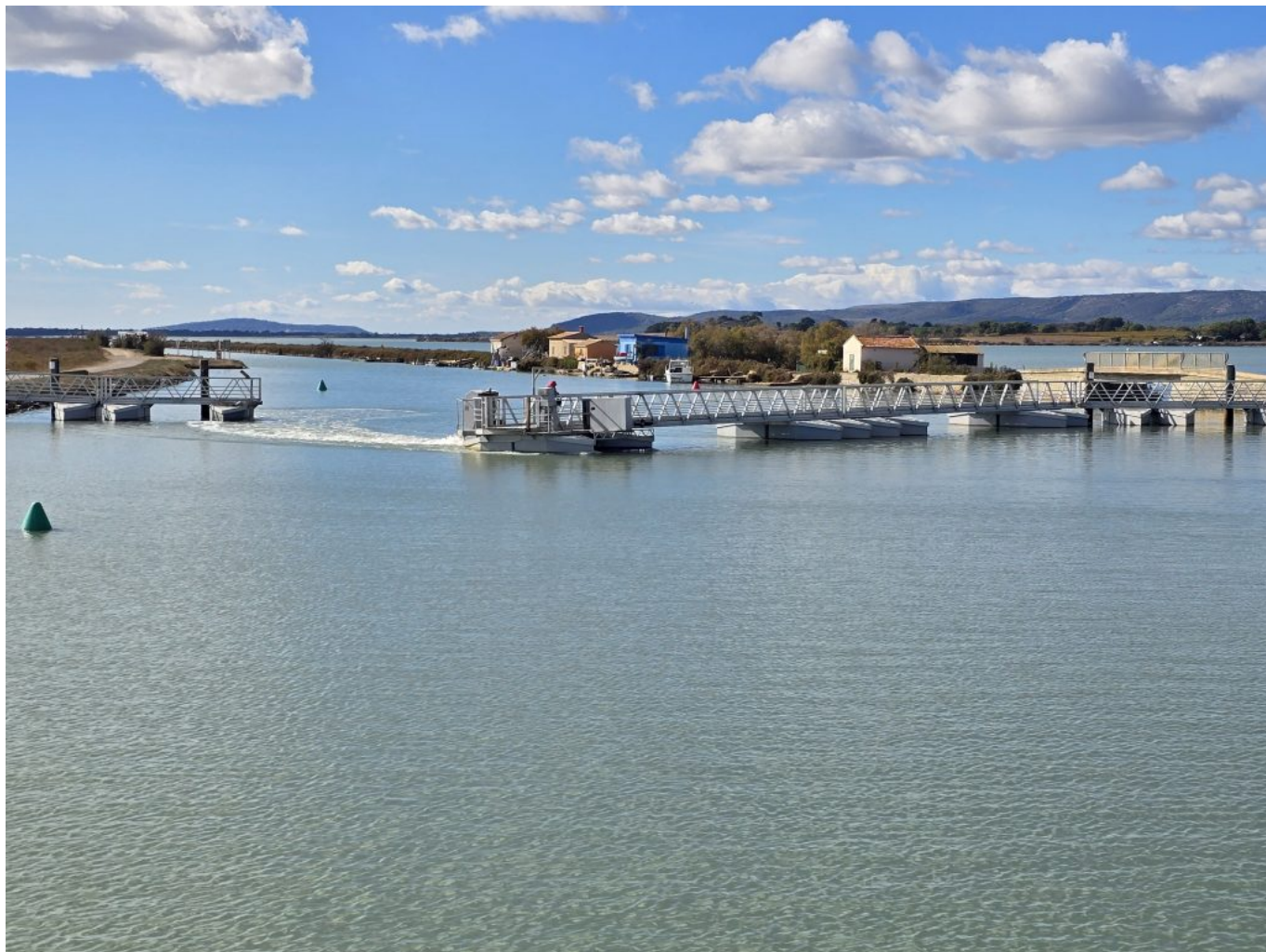
Fußgängerbrücke mit zwei Außenbordmotoren. Bei Anfahrt wird schnell geöffnet....
